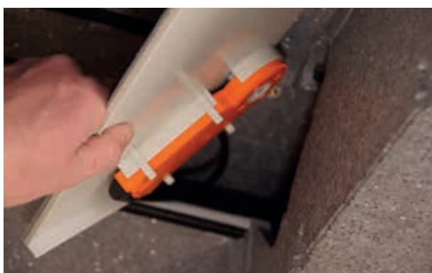
Fjern bypass-aktuator
