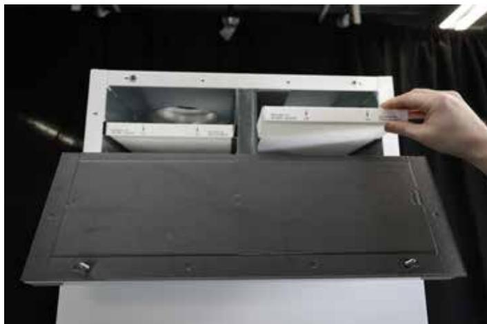
Filtre kan tilgås ved at fjerne de to øverste skruer i den øverste låge, hvorefter filterlågen kan klappes ned.
