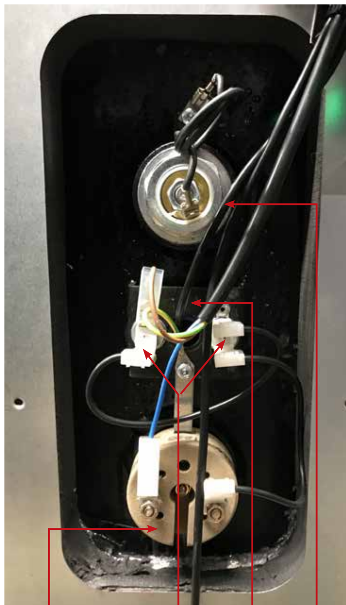
Elpatron Sikkerhedstermostat Temperatursensor T7 Anode
