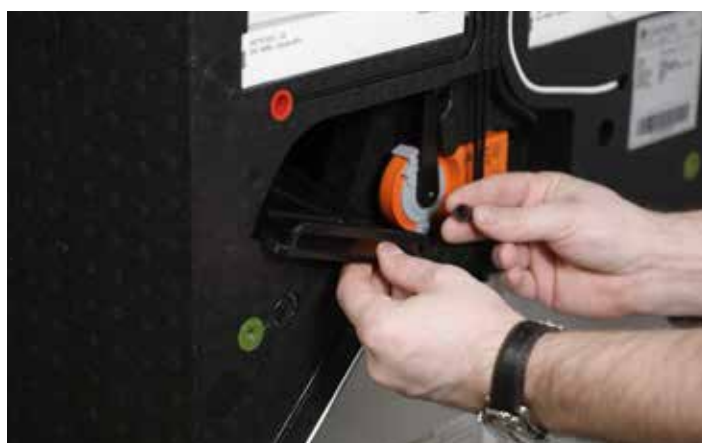
4. Demonter bypass ved at afmontere skruen til motor armen fra bypass klappen. Herefter kan den orange bypass motor klikkes fri af beslaget og motor strømfor- syning demonteres i bunden af motoren.
