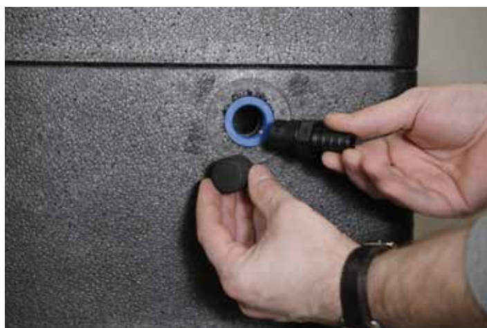
Tilslutning af kondensafløb
