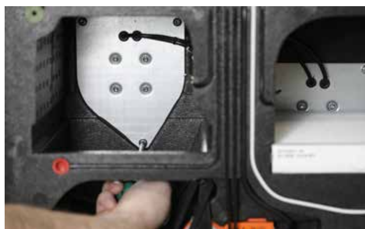
3. Demonter ventilator ved at skrue ventilatorpladen løs - fastholdt af tre skruer i yderkanten af pladen.
