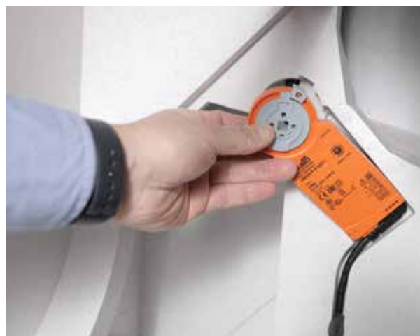
Fjern bypass-aktuator
