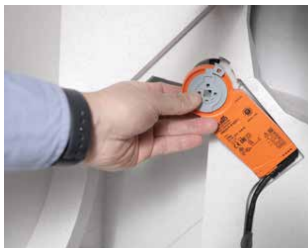
Fjern bypass-aktuator
