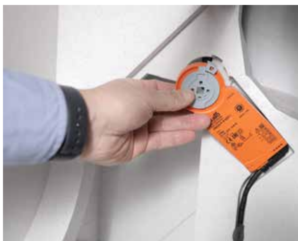
Fjern bypass-aktuator
